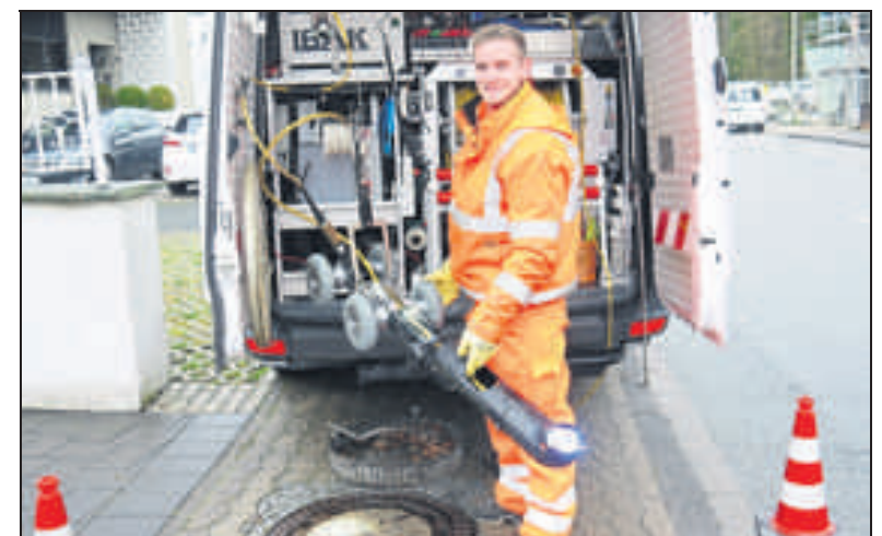
Kanalarbeiter Sebastian Reimann bereitet an der Schlossstraße die Kamera vor, die die Abwasserkanäle untersucht. Dokumentiert wird die abgefahrene Strecke und, wo sich ein Schaden befindet.
